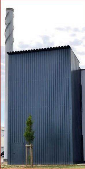
Fig. 33: Exemple d'un silo à pellets encastré pour une installation extérieure
